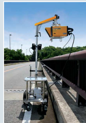
道路際に設置して縁石直下からの計測
